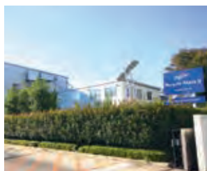
リサイクル・プラザJB外観
