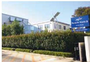
リサイクル・プラザJB外観
